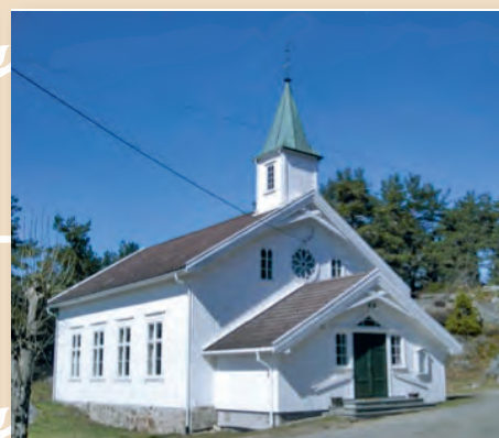
Justøy kapell Brekkestøveien, 4780 Brekkestø
